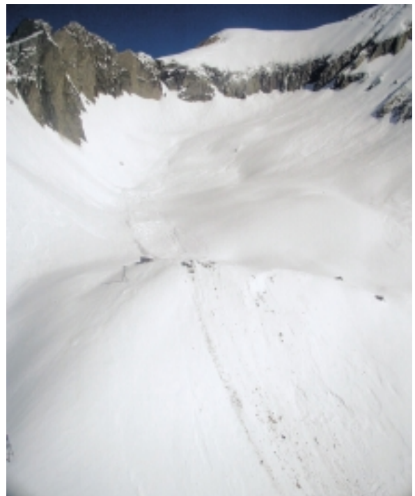
Zerstörte Sajathütte, Aufnahme vom 24. 4. 2001
