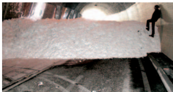
Foto 48: Abgang der Tiefentallawine am 06. 02. 2003 durch eine kleine Öffnung in die Galerie; Steeg-Warth – 07.02.2003 – (© BH Landeck)
