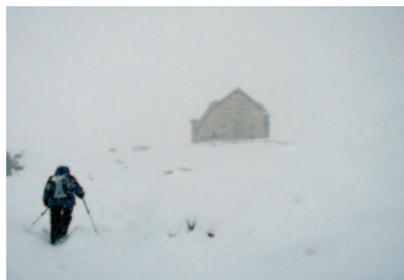
Foto 5: Blick vom Lawinenanriss Richtung Hochhörndlhütte samt Lawinenschutzdamm – 8. 1. 2004 (© Nairz, LWD Tirol)
