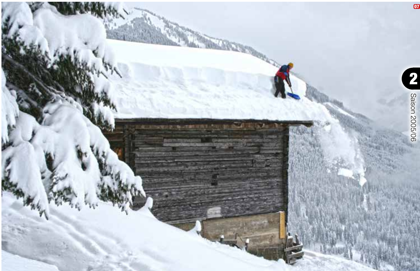
07 Aufgrund der großen Schneemengen müssen teilweise Hausdächer abgeschöpft werden, Kitzbüheler Alpen, 03.01.2006. (Foto: LWD Tirol) |
