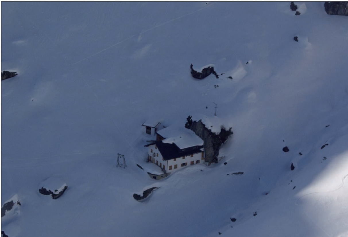
29.01.2008 Muttekopfhütte samt Wetterstation
