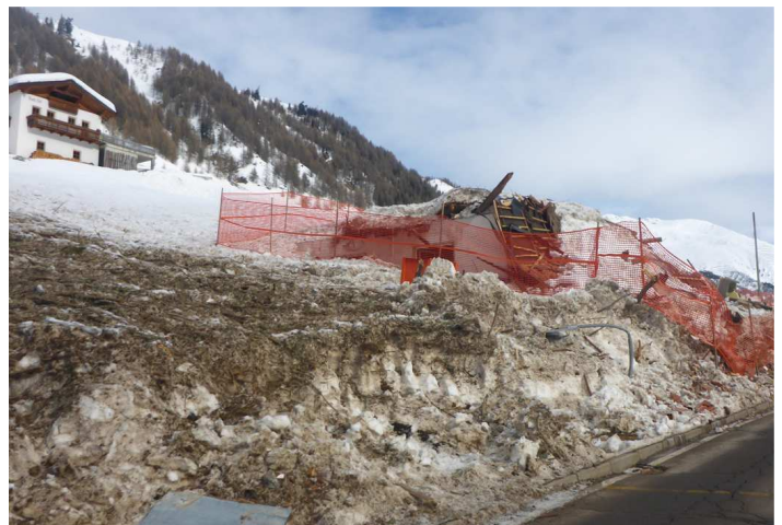
Fig. 23 e 24: sinistra: Pensione Eller, fonte Google Street View; destra: la pensione Eller distrutta (fotografata un paio di giorni dopo l'evento) - fonte SPV Provincia Autonoma di Bolzano - Alto Adige.
