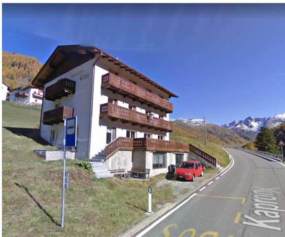
Abb. 23 und 24: links: Pension Eller, Quelle: Google Street View; rechts: zerstörte Pension Eller, ein paar Tage nach dem Unglück, Quelle LWD Autonome Provinz Bozen - Südtirol.
